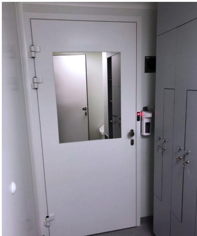
Rys. 1. Drzwi systemowe z pakietem szybowym zlicowanym z powierzchnią drzwi (zdjęcie użyczone przez firmę GBD Clean Room).
