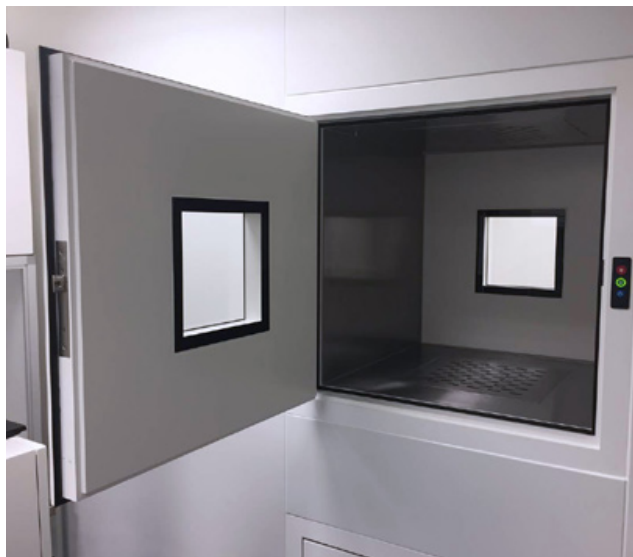
Rys. 2. Okno podawcze aktywne (zdjęcie użyczone przez firmę GBD Clean Room).
